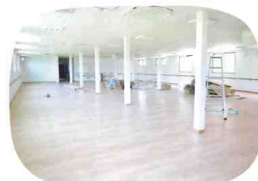
(デイルーム 工事中)
